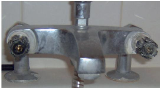
Le corps en laiton se démontera ensuite grâce à une clef plate ou à défaut, une clef à molette.
